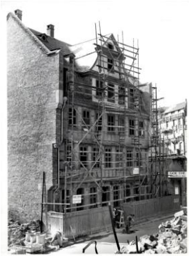
1949_Wiederaufbau mit Gerüst
