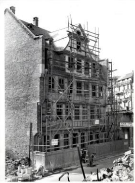
1949_Wiederaufbau mit Gerüst
