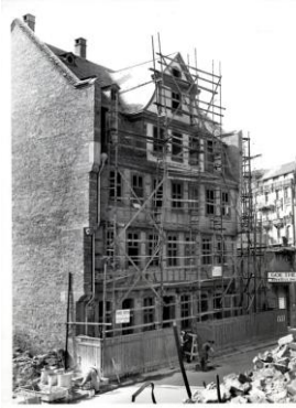
1949_Wiederaufbau mit Gerüst
