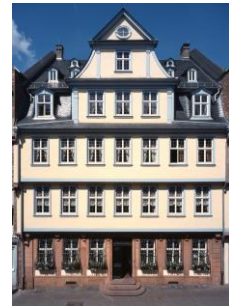
2008 Goethehaus nach Fassadenrenovierung (c) David Hall
