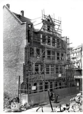
1949_Wiederaufbau mit Gerüst
