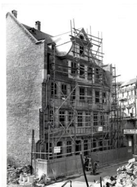
1949_Wiederaufbau mit Gerüst
